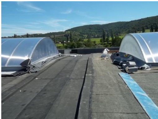
Asfaltová izolace požárních pásů
