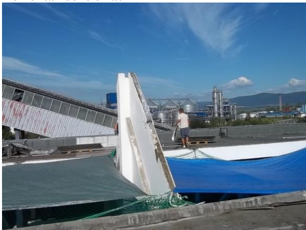
Požární stěna mezi světlíky, ochranné sítě
