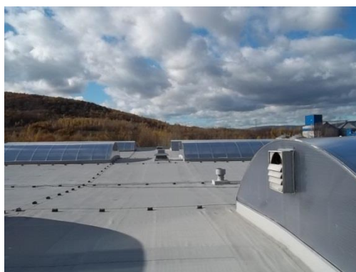
Pohled na střechu od západu
