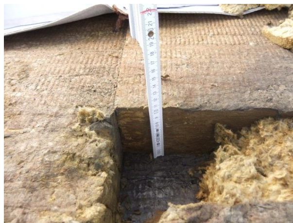
Tloušťka tepelné izolace 100 mm
