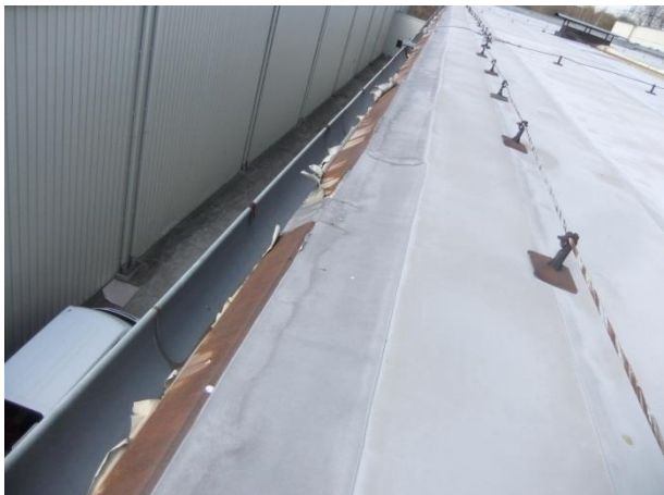
Koroze okapnice
