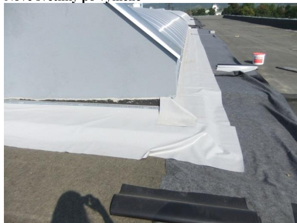
Izolace podstavy světlíku – v popředí požární stěna
