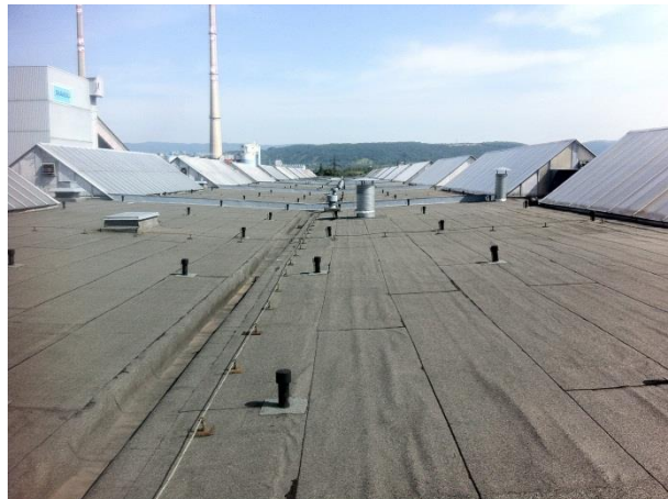
Pohled na stávající střechu od lisovny
