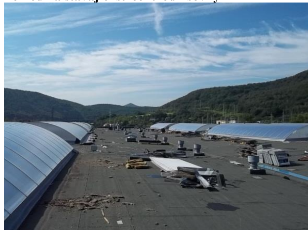
Nové světlíky po výměně
