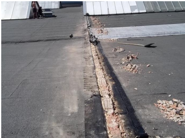
Demontáž dělicích atik
