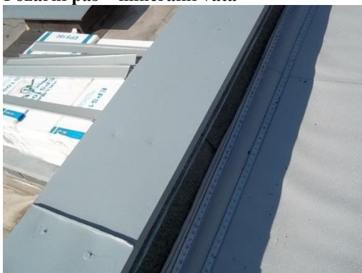
Vzduchotěsné uzavření po obvodě
