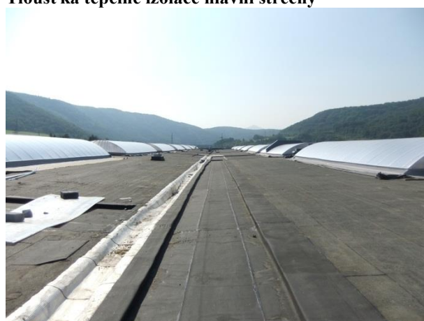
Asfaltové pásy s hliníkovou vložkou
