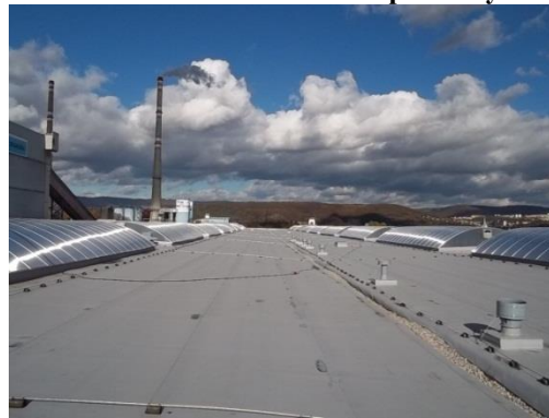
Pohled na střechu od lisovny – kačírek ve žlabu
