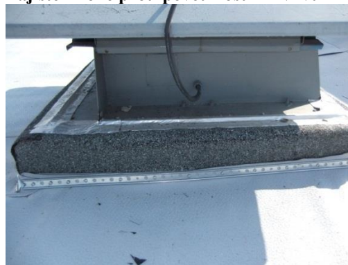
Vzduchotěsné uzavření kolem podstavy VZT
