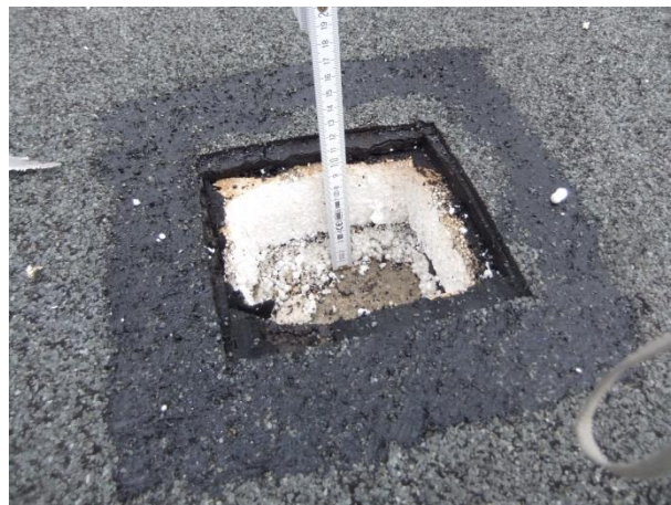
Tloušťka tepelné izolace hlavní střechy
