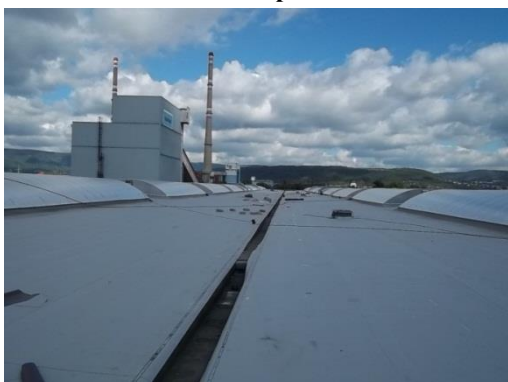
Vzduchotěsné uzavření mezistřešního žlabu
