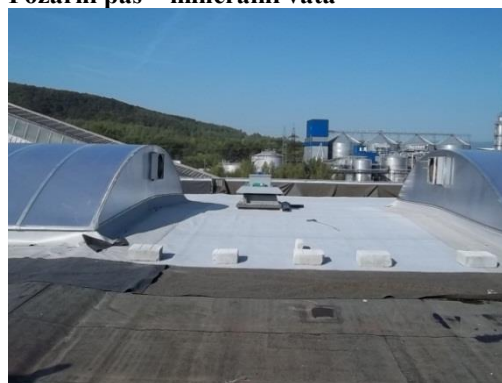
Zajištění fólie proti povětrnostním vlivům
