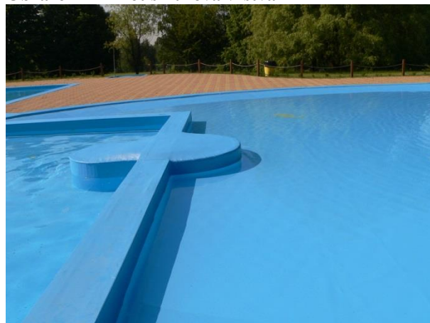
Obr. 4 – Dětský bazén po realizaci
