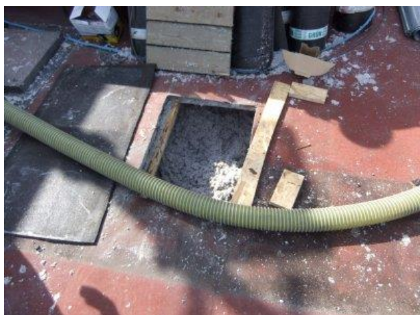
Aplikace foukané tepelné izolace – dutina po vyplnění
