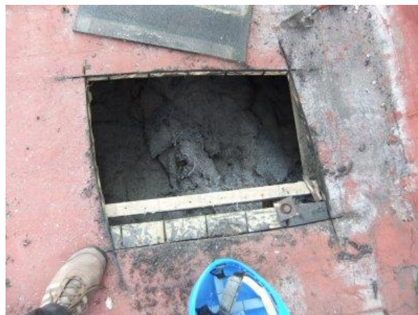
Aplikace foukané tepelné izolace – dutina před vyplněním
