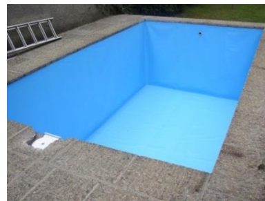
Praha – soukromý bazén
