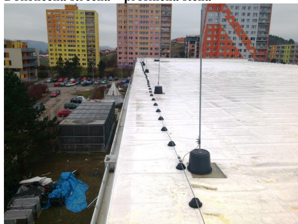
Dokončená střecha - žlab
