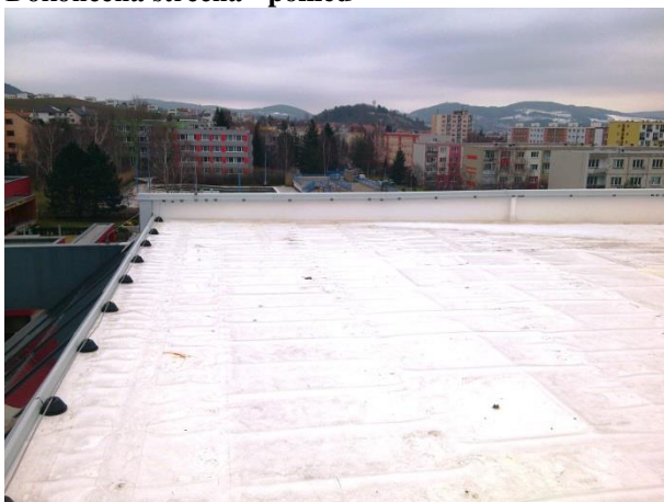
Dokončená střecha – atika
