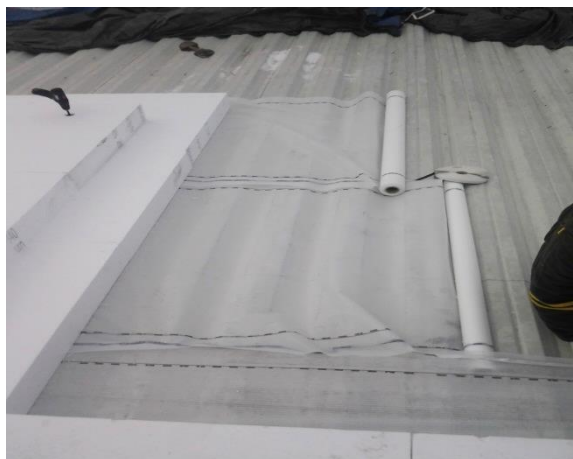
Montáž parozábrany
