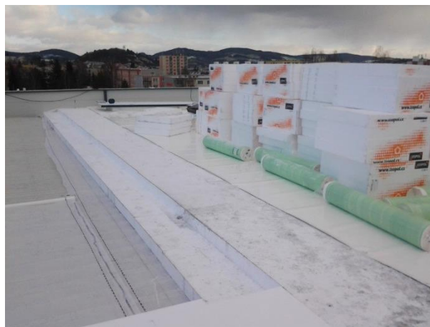
Pokládka tepelné izolace ve dvou vrstvách
