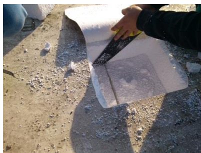
Sonda 2 – tepelná izolace
