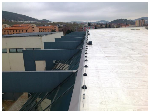
Dokončená střecha – prosklená stěna
