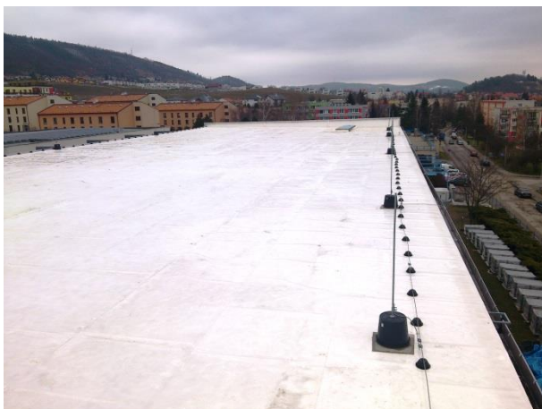
Dokončená střecha - pohled
