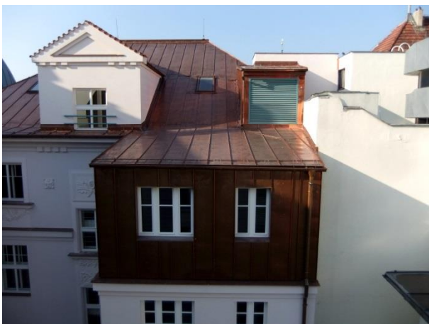
Střecha v atriu
