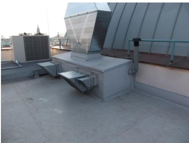
Hydroizolace ploché střechy
