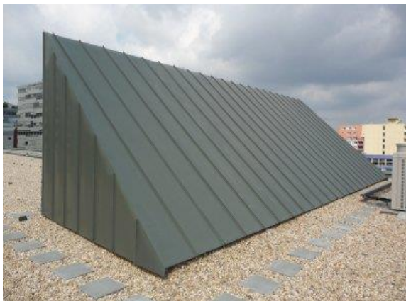
Pohled na střechu světlíku
