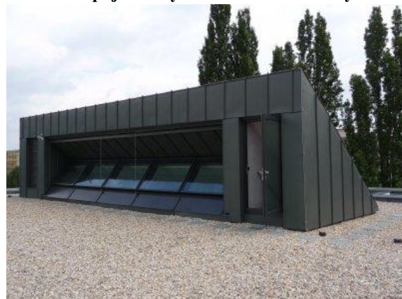
Světlík po realizaci
