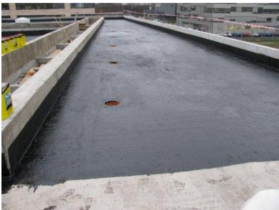
Aplikace penetrační vrstvy z asfaltové emulze
