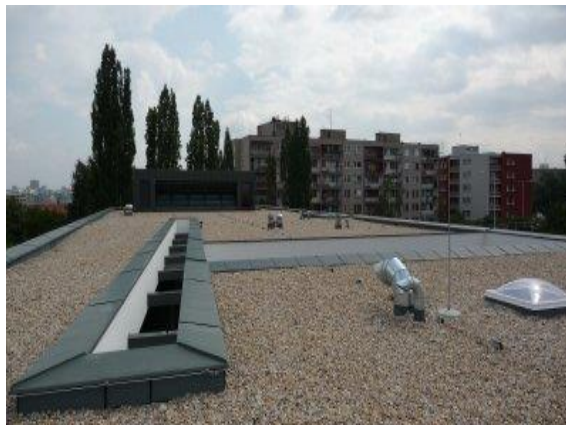
Pohled na střešní rovinu po realizaci
