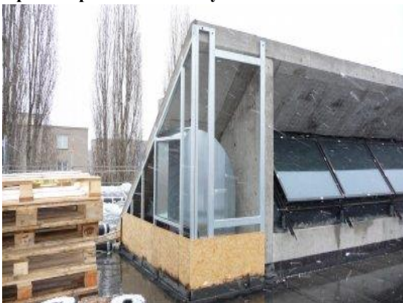
Opláštění světlíku OSB deskami
