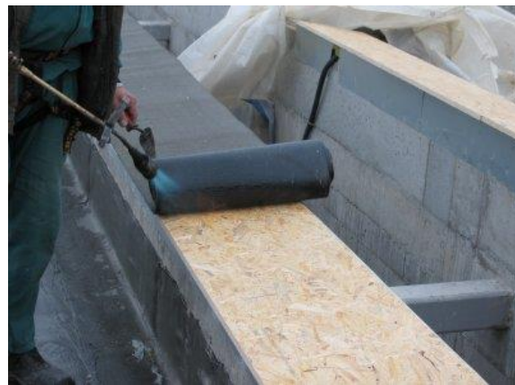
Provedení pojistné hydroizolace OSB desky atik
