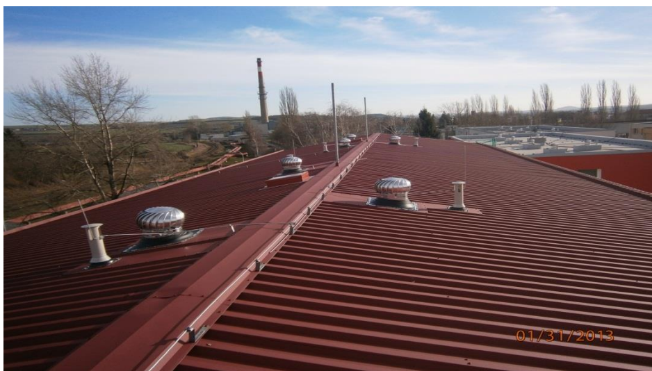
Obr. 11: Dokončená střecha z ptáčí perspektivy
