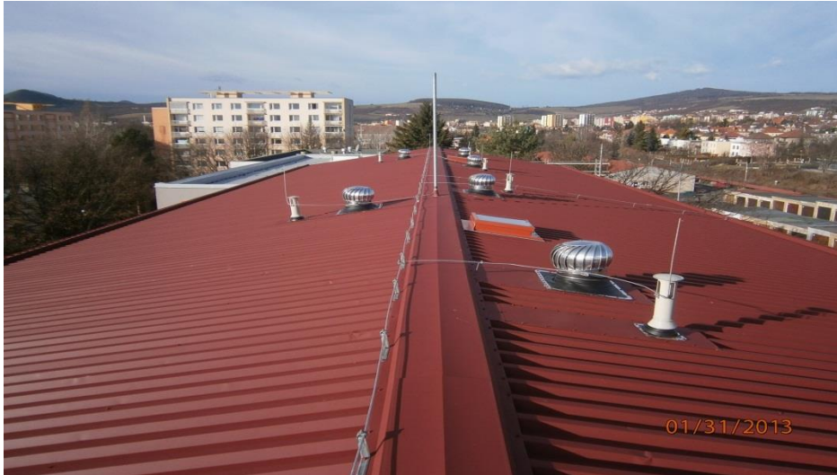
Obr. 12: Pohled na hřeben
