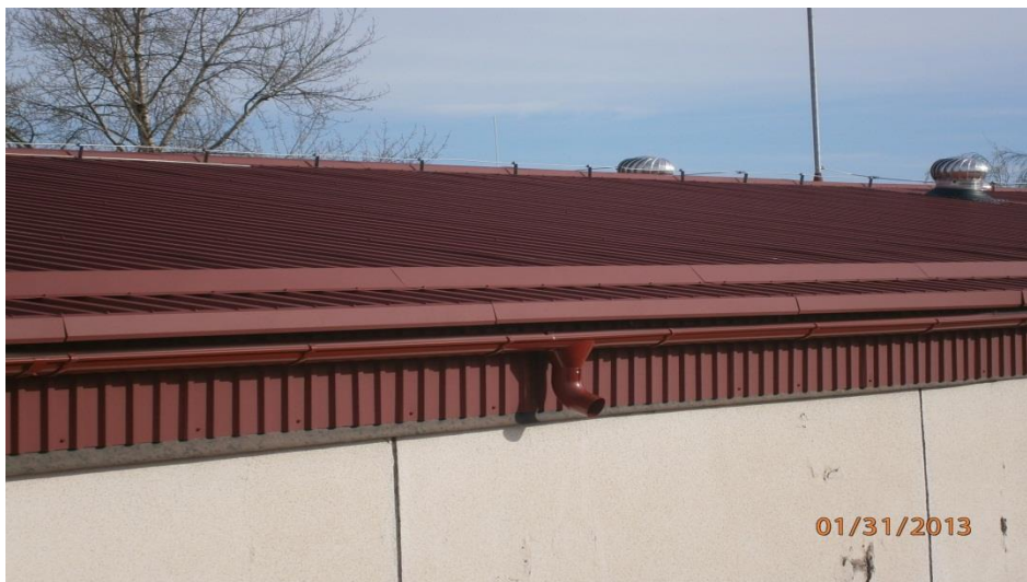
Obr. 9: Pohled na odvodnění střechy
