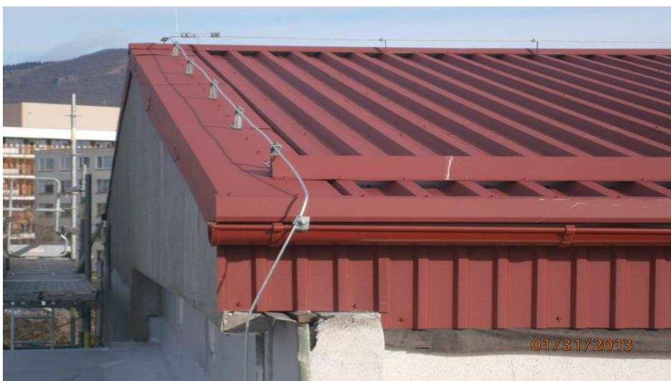
Obr. 8: Pohled na štít – dokončený
