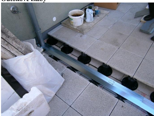
Napojení svodu na odtokový žlab
