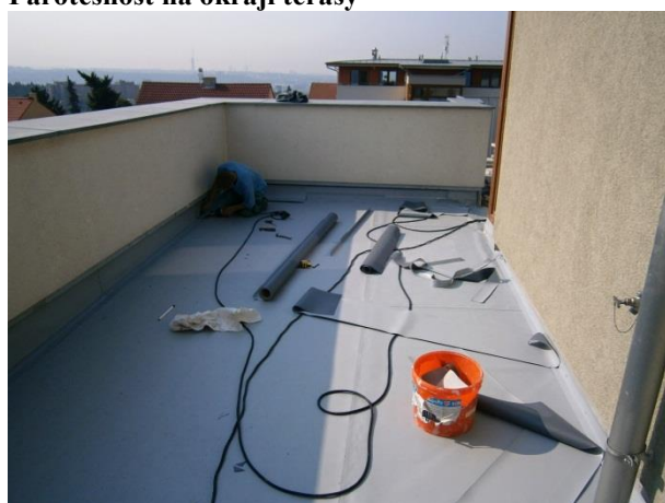
Hydroizolace v ploše terasy
