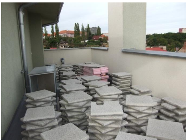
Skládka původních betonových dlaždic
