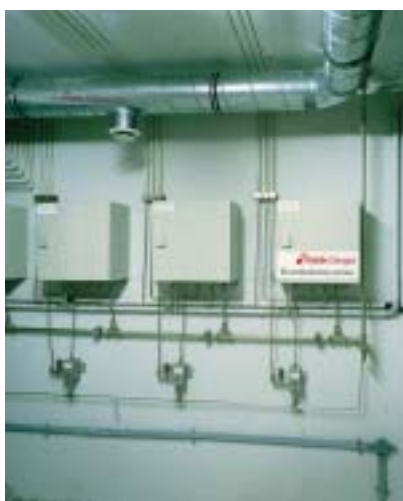
Uspořádání pneumatického zpoždění pro 4 hasební úseky
