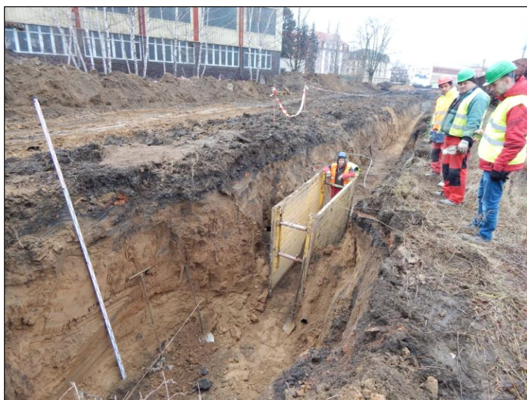
Obr. 02. Děčín-Podmokly. Ulice Práce, výkop kanalizace.
