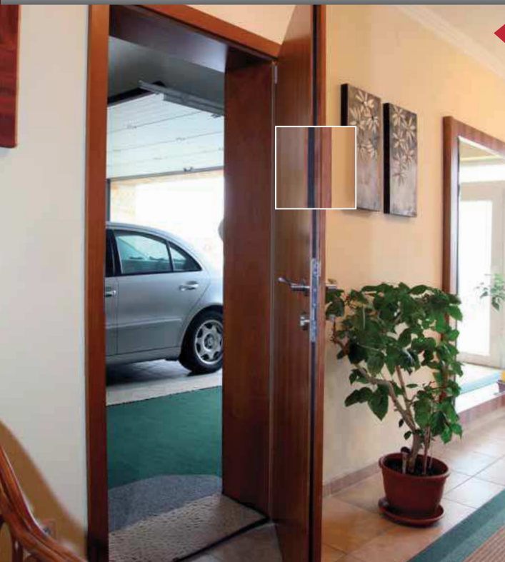
Požární zpěňovací páska po obvodu dveří
