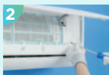
Odstraňte šroub na ovládací skříňce
