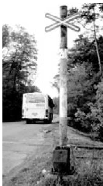
O stavu železničního přejezdu mezi Ratíškoviciemi a Vacenovicemi nejlépe vypovídá rezavý sloup bývalého návěstidla. Foto Petr Fridrich
