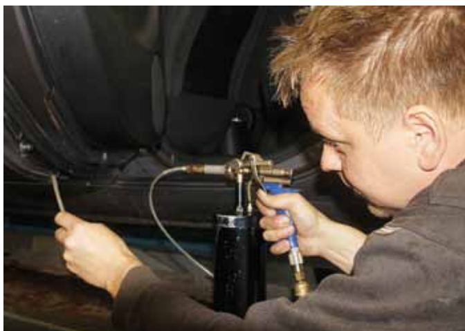
Na rozdíl od lemů a prahů dutiny nelze vizuálně kontrolovat. Jejich preventivní ochranu doporučujeme u všech vozů starších vozů.
