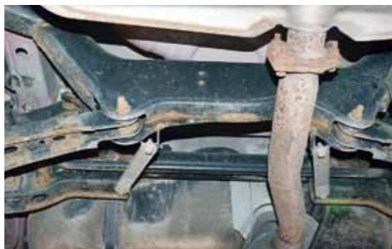
Čtyřleté Mitsubishi Lancer: povrchovou korozi kolem svarů zadní nápravnice ještě zpomalí abroušením a konzervací.
