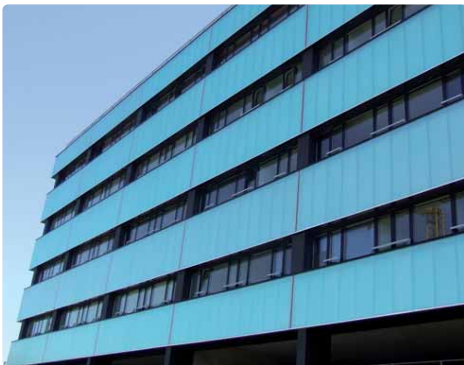
PRŮSVITNÉ OBVODOVÉ OPLÁŠTĚNÍ Provedení vertikálního průsvitného opláštění
