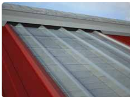
DETAIL HŘEBENU Detail hřebenu s těsněním LDPE záslepkou.
