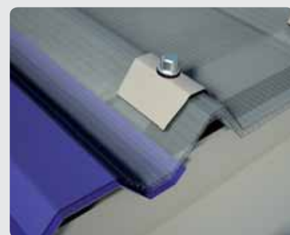
UKOTVENÍ ZASTŘEŠENÍ Provedeno vyvrtáním a vložení Vipla šroubku, hliníkové čepičky s těsněním.
