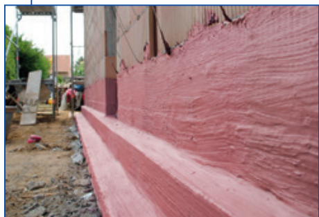
Bezešvá izolace mezi základy a zdivem (stěrka je připravená pro nanášení cementových lepicích a omítkových materiálů)
