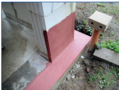
Příprava stěny na povrchovou úpravu a bezešvé napojení na vodorovnou konstrukci
