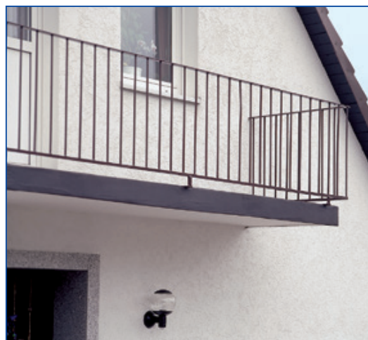
Použití jako ochrana proti karbonatci vyztužené betonové konstrukce u balkonové konzole
