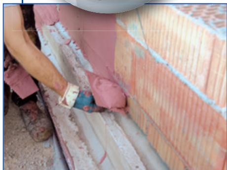
Aplikace hladítkem na zdivo v těsné blízkosti terénu
