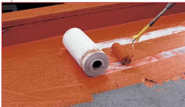
3. Do první vrstvy je nezbytné vložit výplňovou tkaninu DAKORIT® DV110 89V
