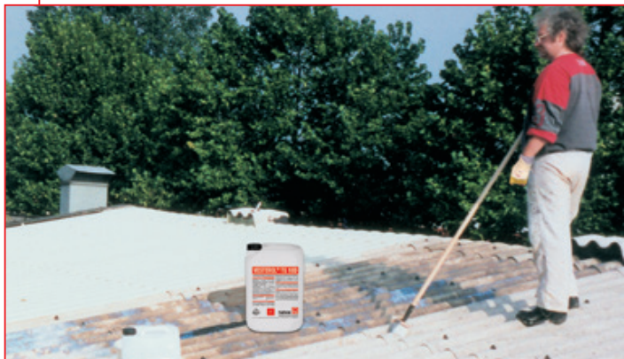
1. Na nasávkavé podklady se používá penetrace VESTEROL® TG 10D
