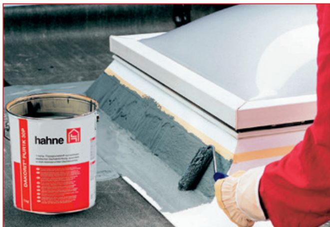
Nanesení první vrstvy na oba podkladní materiály
