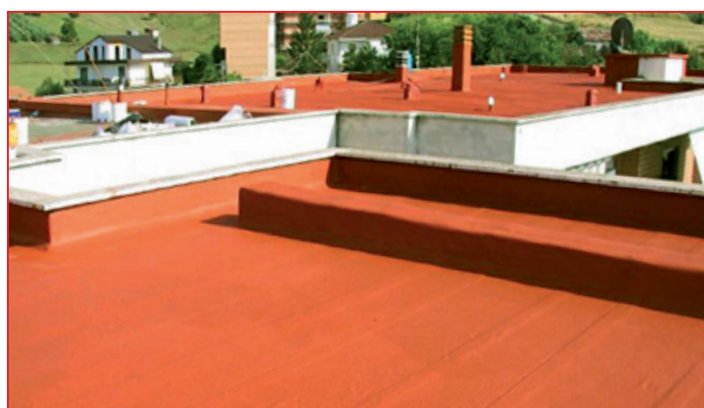
5. Konečný výsledek renovace ploché střechy
