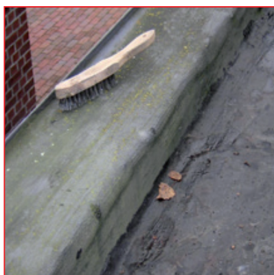
Příprava podkladu – mechanické očištění, oprava trhlin a bublin
