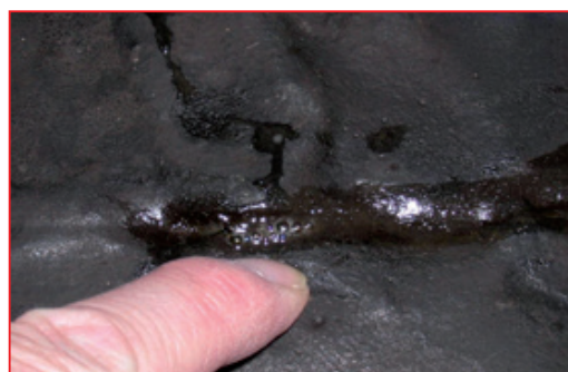
Příprava podkladu – mechanické očištění, oprava trhlin a bublin
