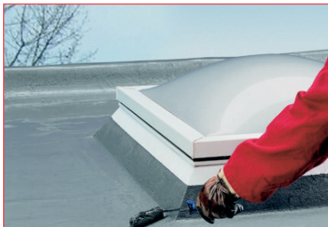
Po úplném zaschnutí první vrstvy v tkanině se spoj ošetří vrchním ochranným nátěrem
