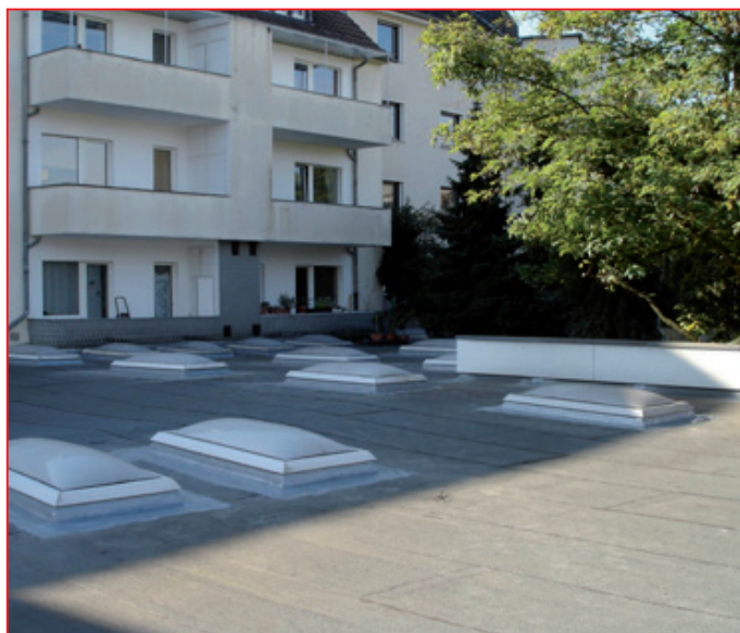
Výsledkem je dokonalé, dlouhodobě spolehlivé a velmi rychlé utěsnění problematických spojů např. u světlíků
