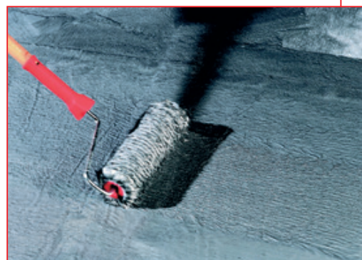
Po úplném zaschnutí první vrstvy v tkanině se nanáší vrchní ochranný nátěr
