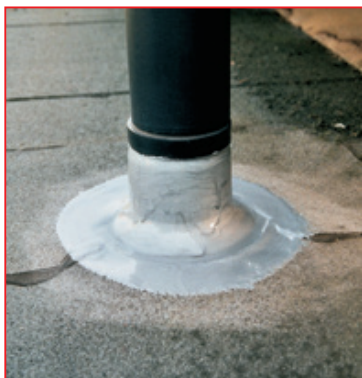
Renovace a dokonalé utěsnění odvětrávacího potrubí
