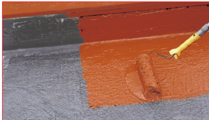
2. Aplikace pomocí válečku, štětky nebo strojním stříkáním
