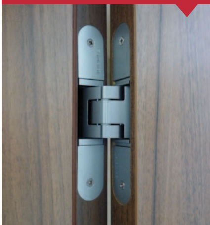
Detail skrytého pantu
