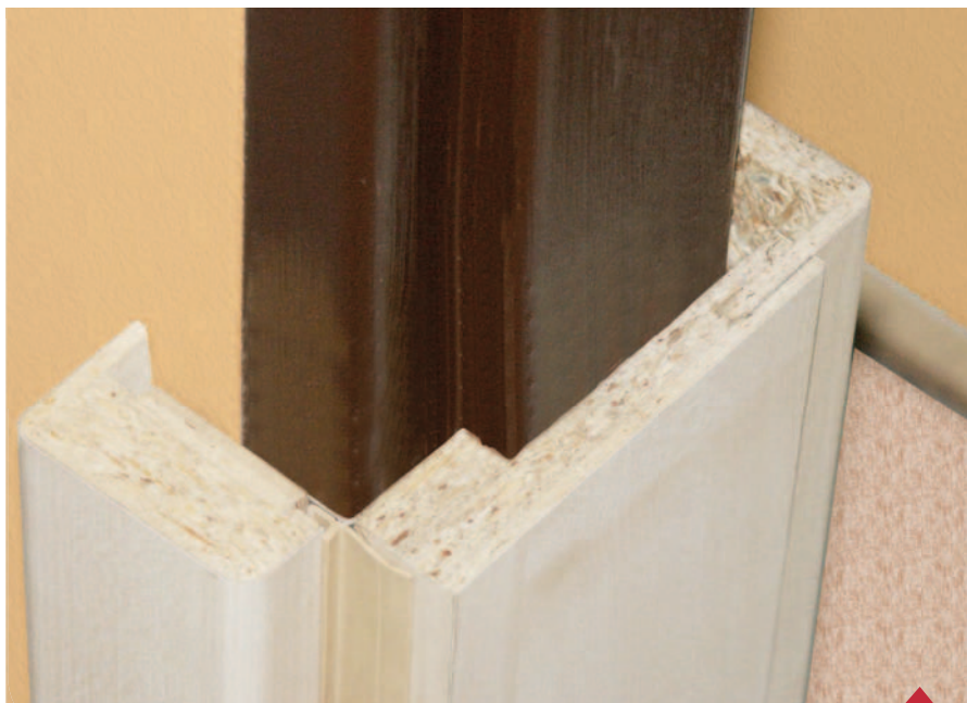
Řez obkladem kovové zárubně
