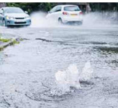
Zaplavené ulice po silném dešti: Naše kanalizace přetékají stále častěji.
